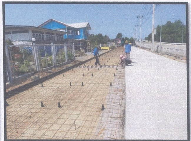
ภาพถ่าย ขั้นตอนเทพื้นคอนกรีต 350 KSC. พื้น ผิวจราจร ค.ส.ล
