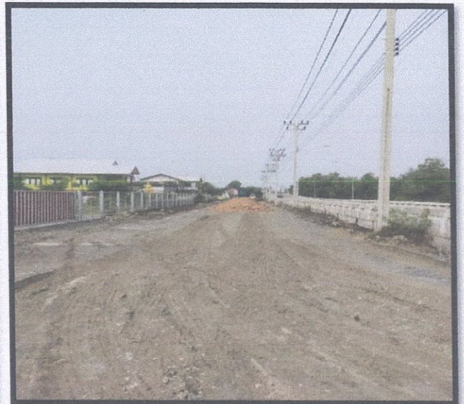
ภาพถ่าย ขั้นตอนงานบดอัดพื้นทางเดิมและบดอัดชั้นรองพื้นทางลูกรัง
