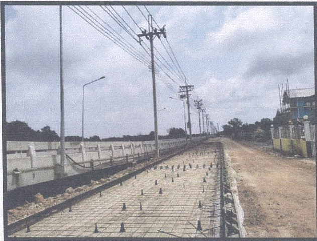
ภาพถ่าย ขั้นตอนเทพื้นคอนกรีต 350 KSC. พื้น ผิวจราจร ค.ส.ล
