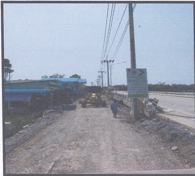
ภาพถ่าย ขั้นตอนงานบดอัดพื้นทางเดิมและบดอัดชั้นรองพื้นทางลูกรัง
