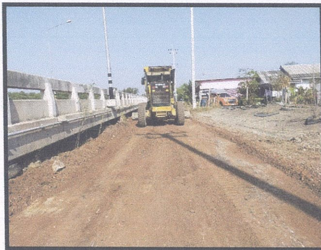
ภาพถ่าย ขั้นตอนงานก่อสร้างรองพื้นทางลูกรัง
