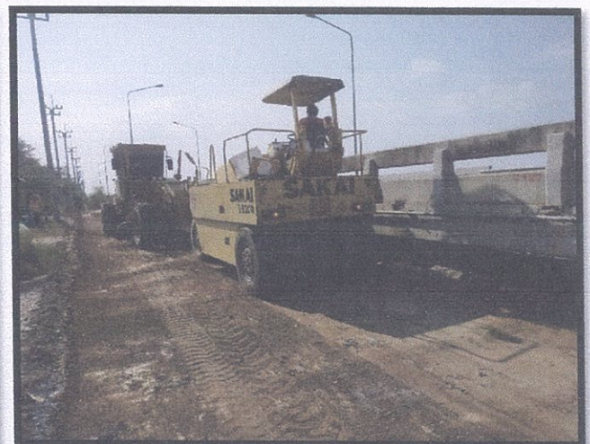
ภาพถ่าย ขั้นตอนงานก่อสร้างรองพื้นทางลูกรัง
