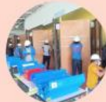
ช่างเดินสายไฟฟ้าภายในอาคาร
